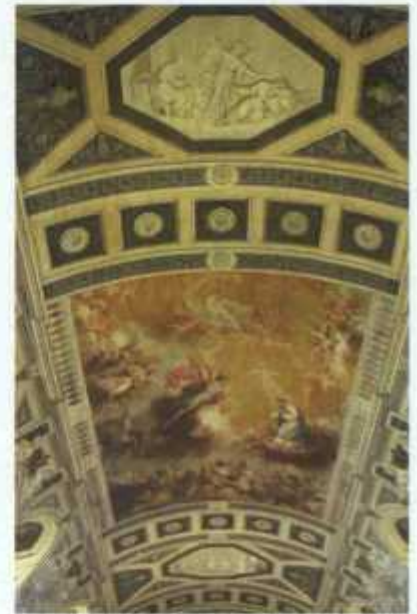
Tecto da nave central após restauro ©Junqueira 220
